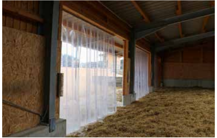
Die Öffnungen der Liegehalle des Aktivstall Martinshof haben Lamellenvorhänge. So bleiben die Pferde in der Halle vor Wind und Wetter geschützt.
