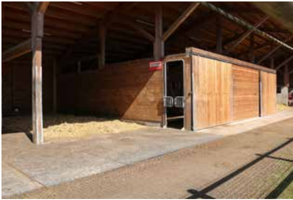
Auf der Reitanlage Schlarbhofen führt der Weg in die Liegehalle erst über eine mit Offenstallgittern befestigte Fläche und anschließend über Gummimatten.
