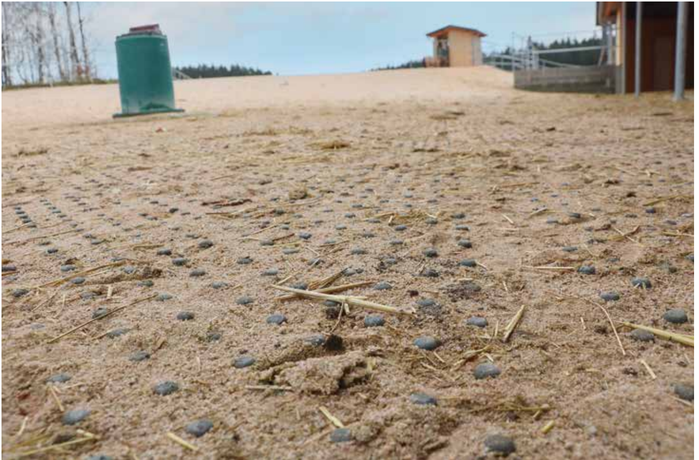
So kann ein befestigter Offenstallboden im Detail aussehen.
