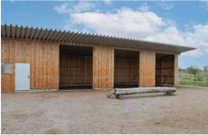
Die Liegehalle auf dem Pferdehof Luppmanns verfügt über drei große Öffnungen, damit problemlos mehrere Pferde rein und raus können und immer eine Fluchtmöglichkeit besteht.
