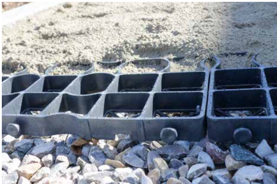
Eine Bodenbefestigung im Querschnitt, bestehend aus Schotter, Paddockgitter und Sand.
