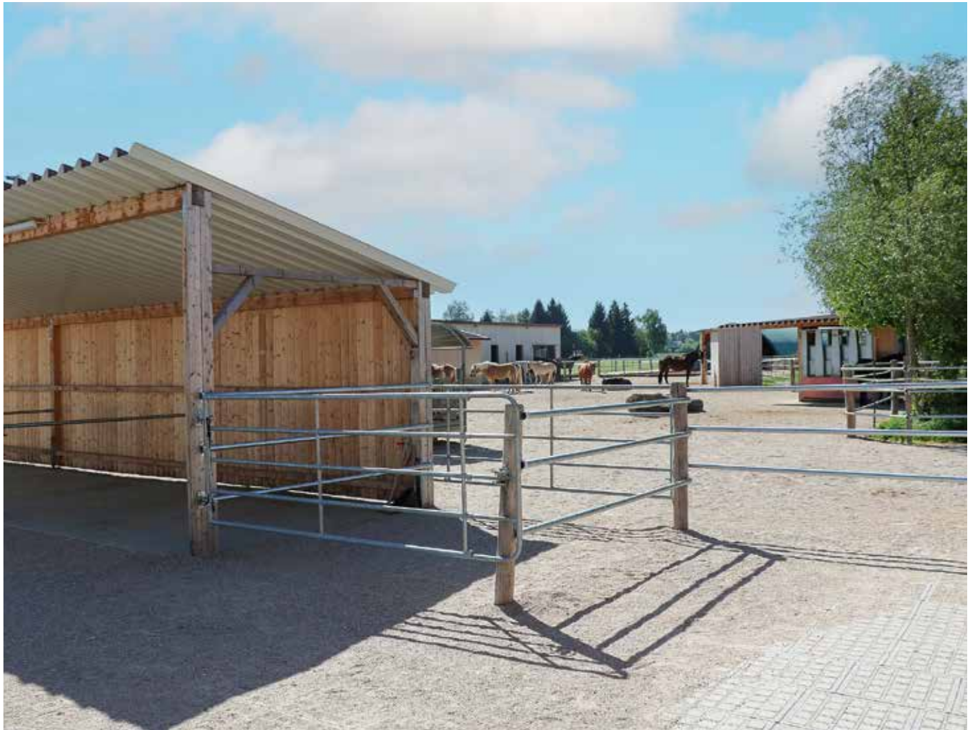
Auf dem Schwabhof wurden an den Ein- und Ausgängen der Offenställe Schleusen gebaut, damit sich die Pferde beim Holen leichter separieren lassen.
