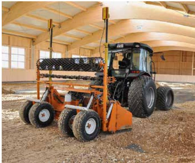
Bei dieser Reithallenbodensanierung trug das Team von KHB Heuschmid die alte Tretschicht zunächst ab und gab neues Sand-Vlies-Gemisch auf. Dieses wird nun gleichmäßig verteilt.
