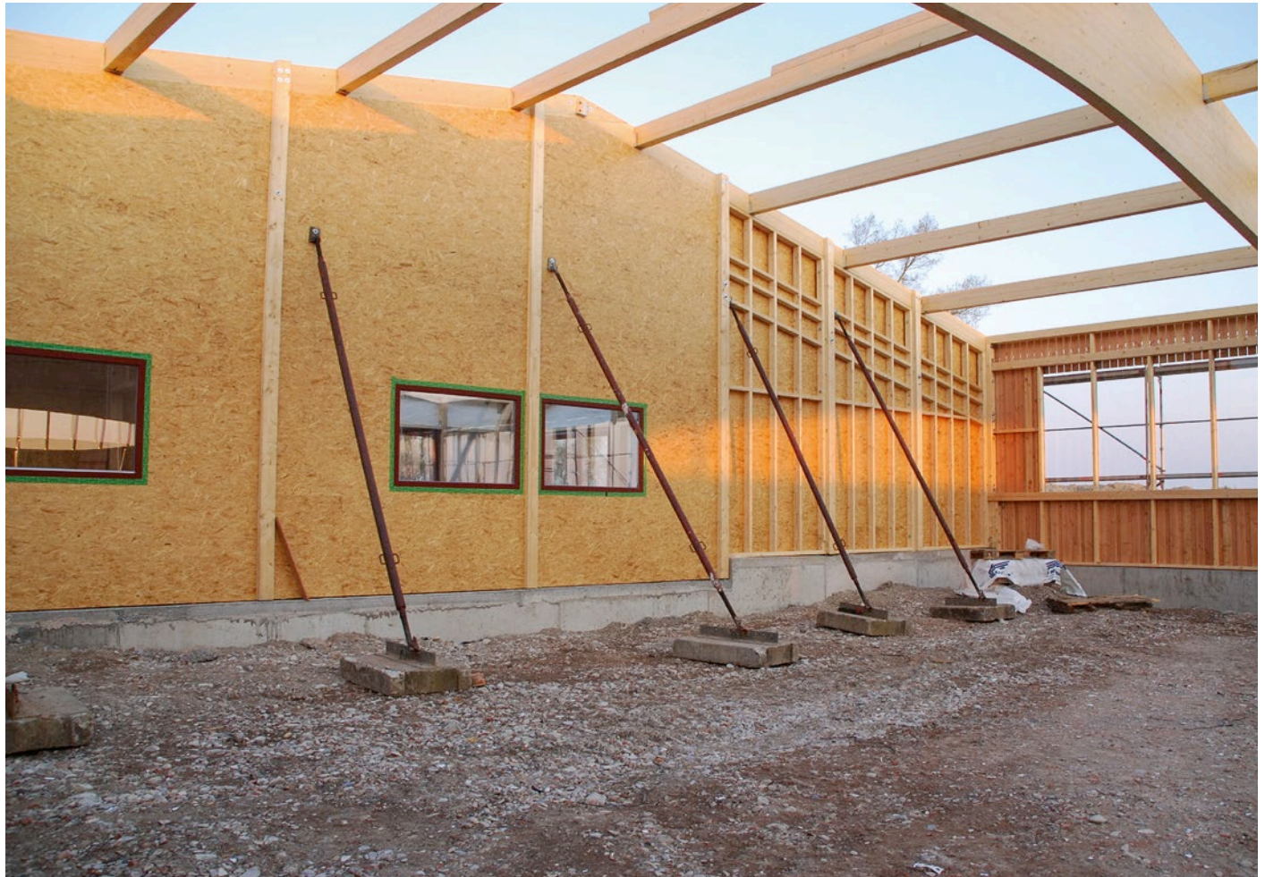
Bogenbinder und Pfetten sind montiert – das Dach fehlt noch.
