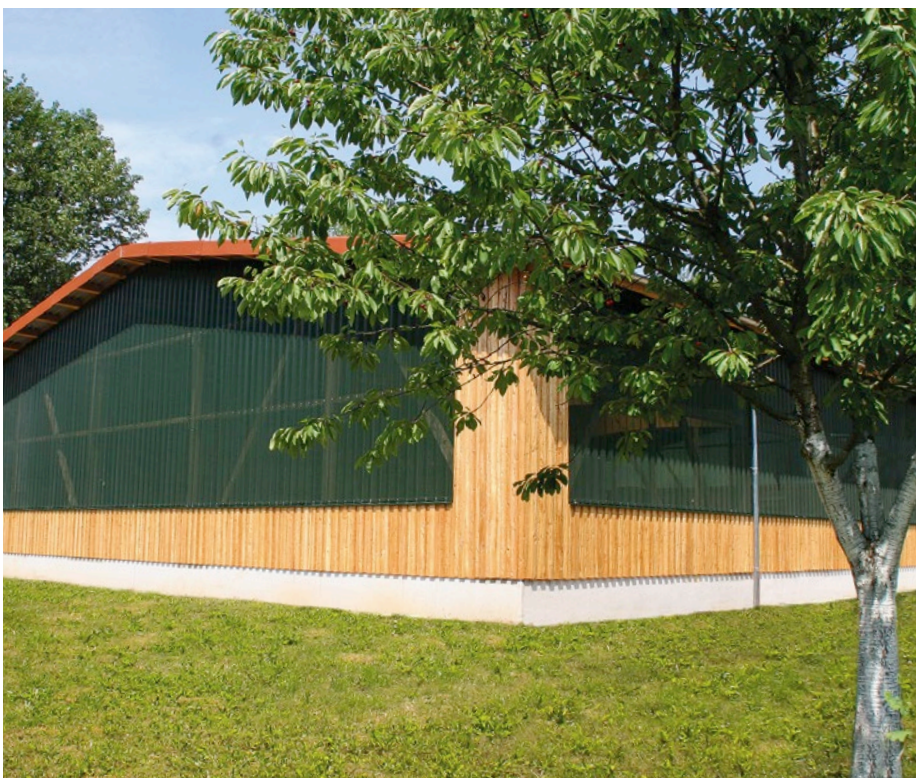
Mit Lochblechen ausgestattete Reithallen bieten eine gute Luftzirkulation.
