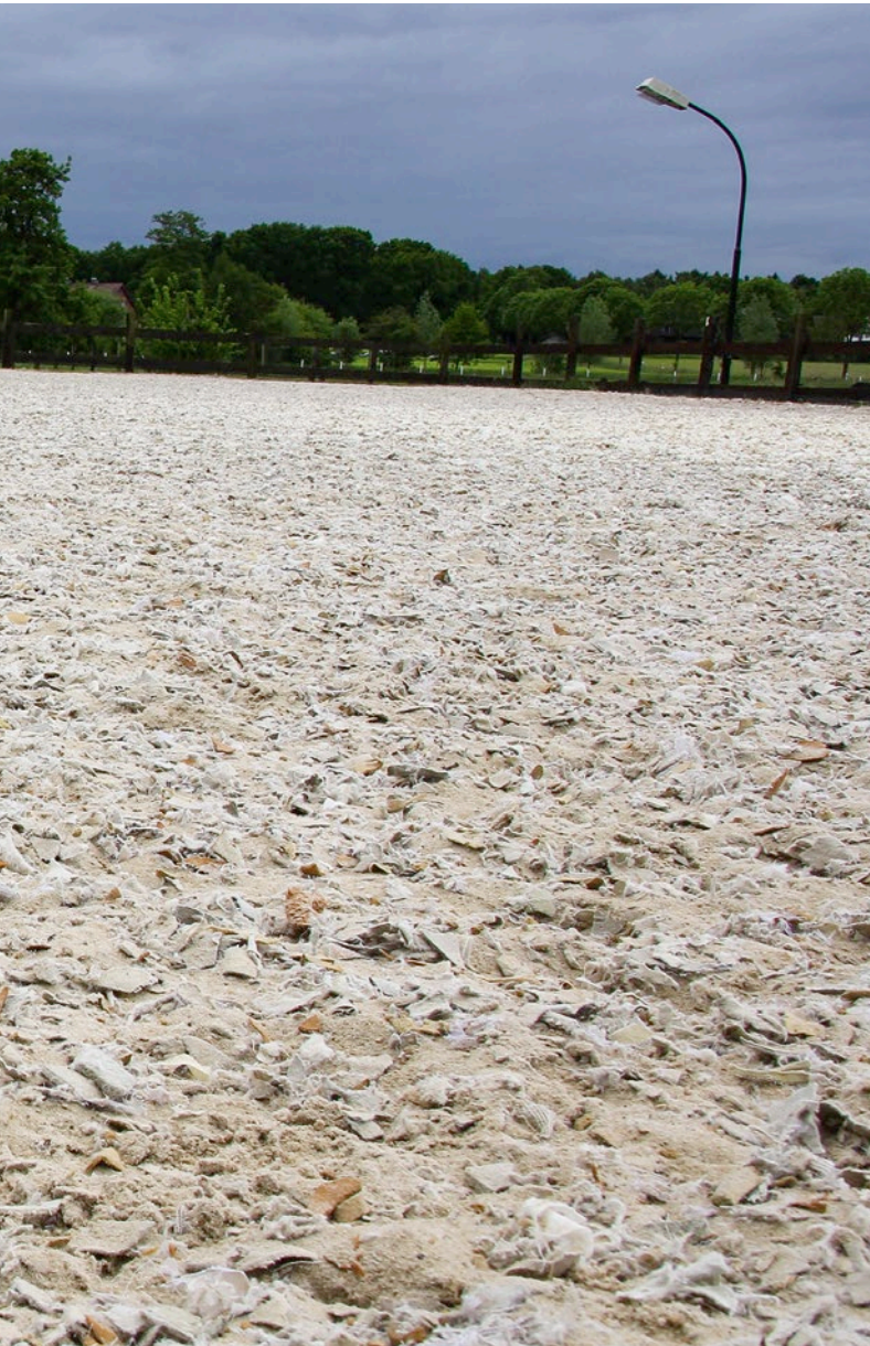
Ein Außenplatz mit einer Tretschicht aus Sand-Vlies-Gemisch.
