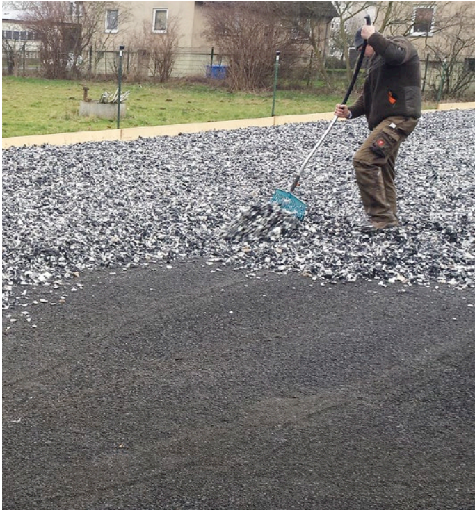
Die Textil-Flocken kommen ohne Trennschicht direkt auf den Schotter.
