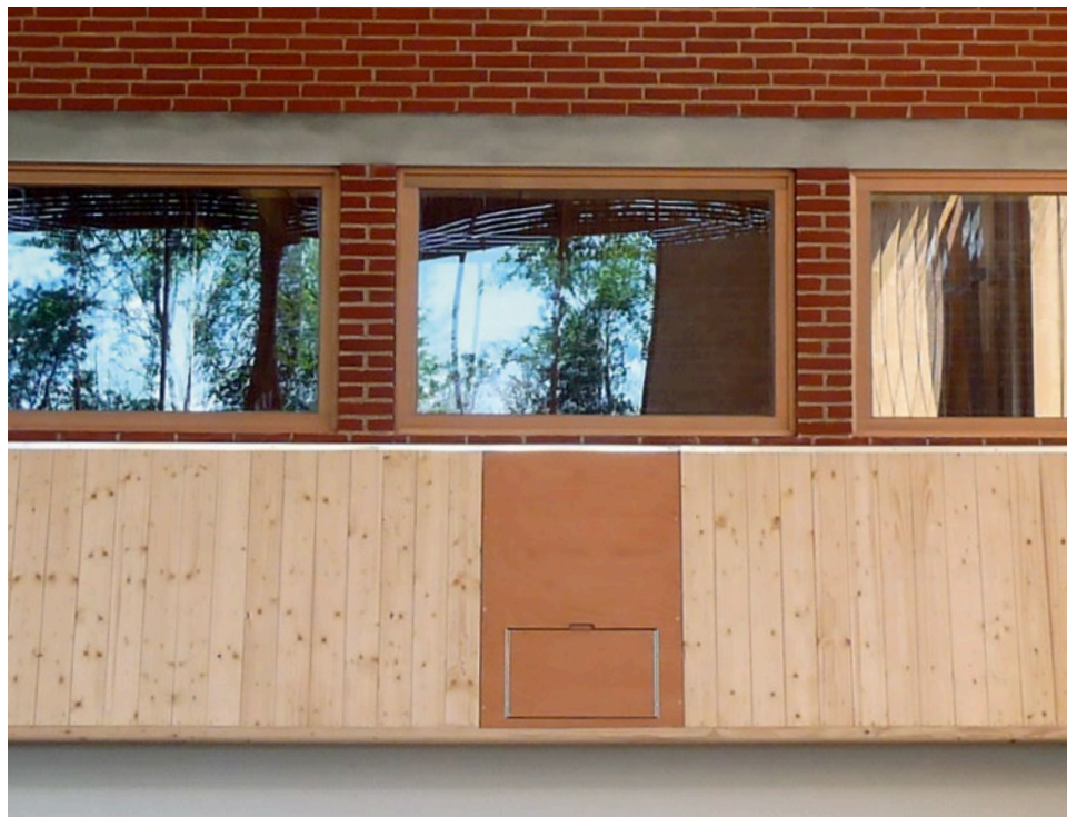
Wird sie nicht gebraucht, ist die Aufstiegshilfe in der Bandenwand eingeklappt.
