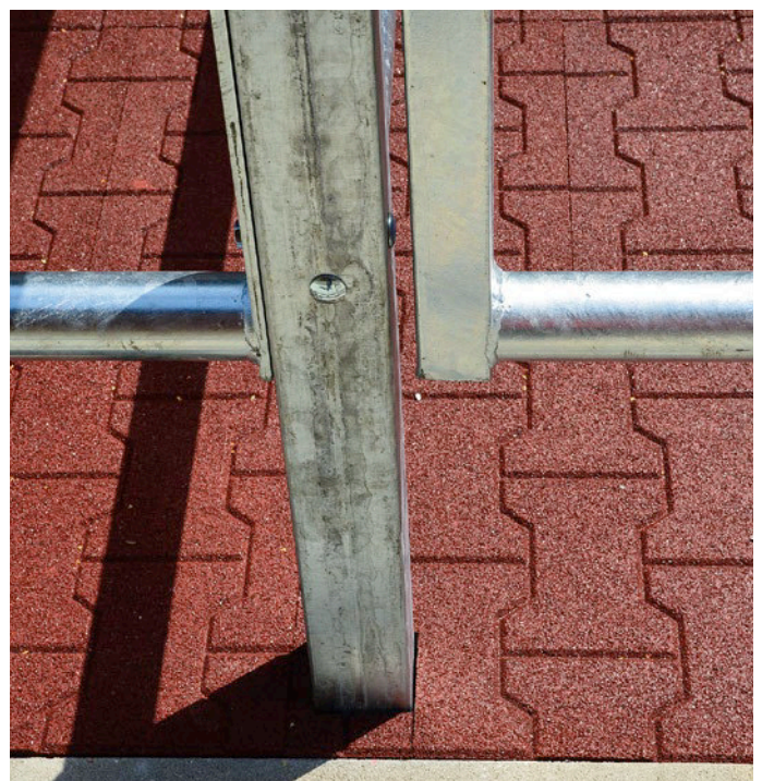
Die H-Stein-Platten für Hau können auch als Paddockuntergrund verwendet werden.
